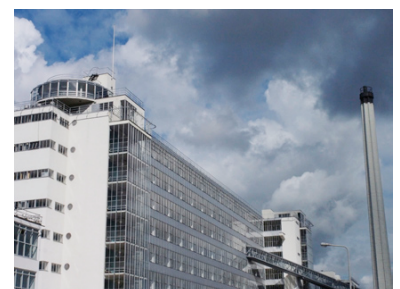
186.4 Van Nellefabriek, Rotterdam, Johannes Brinkmann/Leendert van der Vlugt, 1923–31
